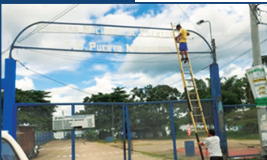
Imagen n.º 16 Operaciones de mantenimiento Terminal Portuario de Puerto Maldonado
