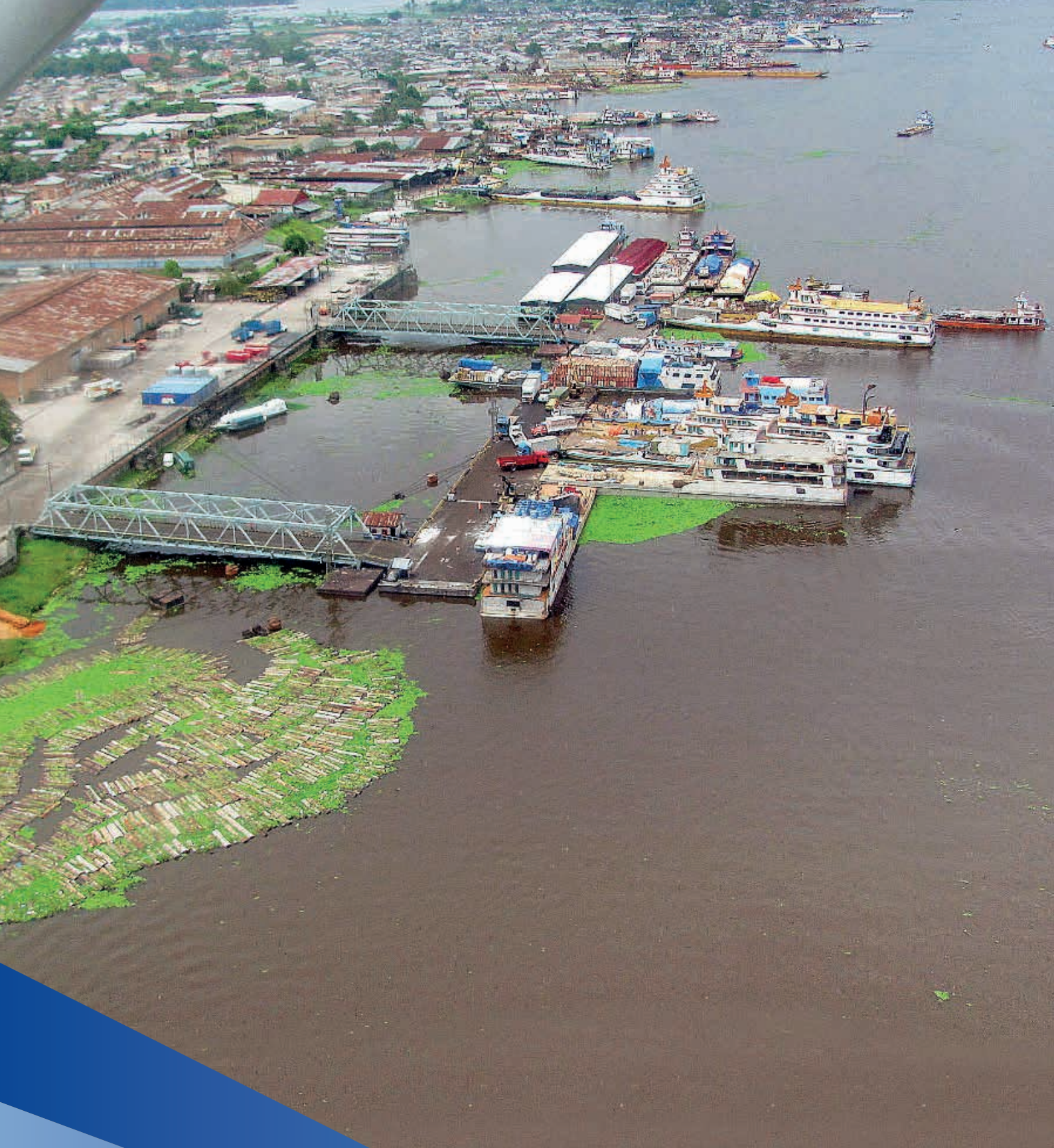
Terminal Portuario de Iquitos
