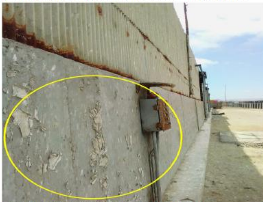
CALAMINAS EN MAL ESTADO REQUIEREN TRATAMIENTO
