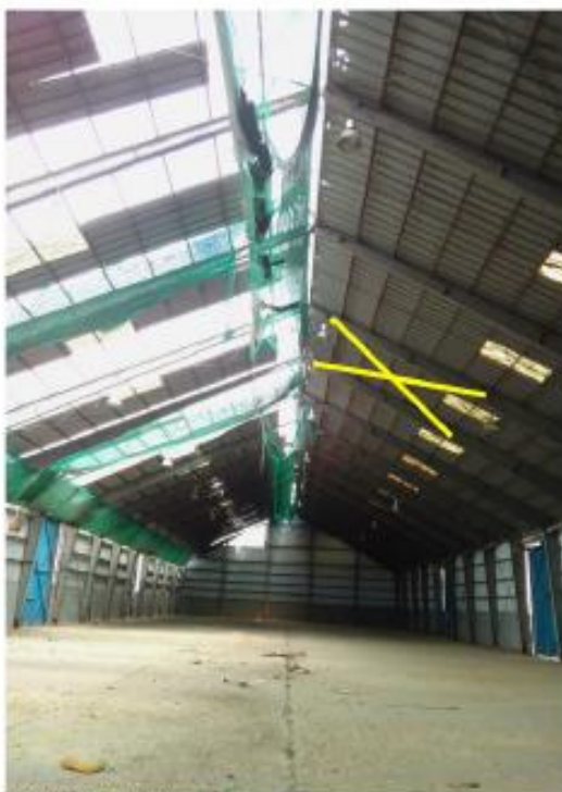
TENsores EN TECHO 10 POR LADO IMAGEN: VISTA DE TENsoRES (TIJERALES) EN TECHO, EL CUAL DEBE SER CONSIDERADO EN MANTENIMIENTO
