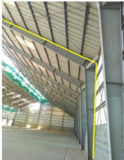
COLUMNAE 17 POR LARGO MEDIDAS 6,00X 14 DE CTMC
