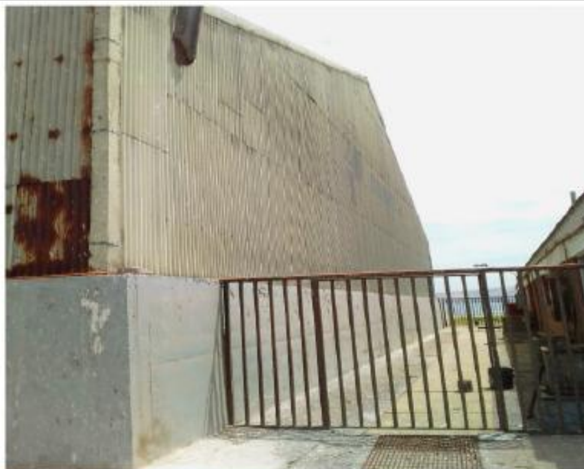
CALAMINAS EN MAL ESTADO REQUIEREN TRATAMIENTO
