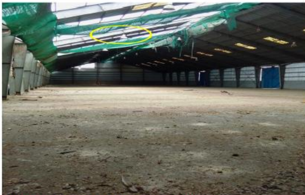
IMAGEN: VISTA DE TECHO DE ALMACÉN, VISTA SUPERIOR
