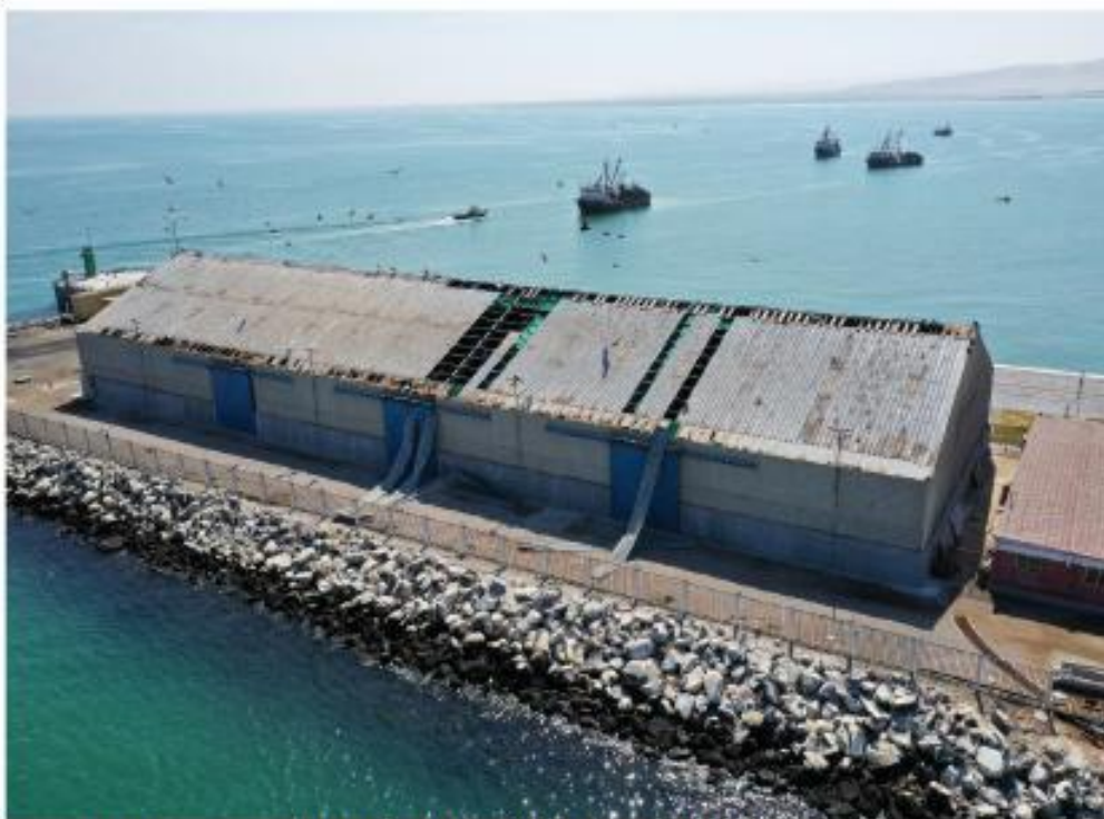
IMAGEN: VISTA DE TECHO DE ALMACÉN, VISTA SUPERIOR
